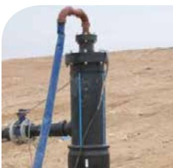
**Gambar 4.18:** Contoh pangkal sumur yang dipompa (selang fleksibel biru untuk menghilangkan lindi melalui pompa submersible dalam sumur gas, dan gas diambil dari sisi sambungan dan dikontrol menggunakan katup kupu-kupu)
