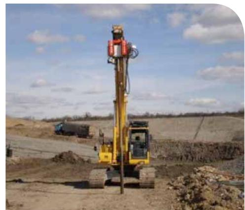
Gambar 4.13: Instalasi sumur pin menggunakan eskavator
