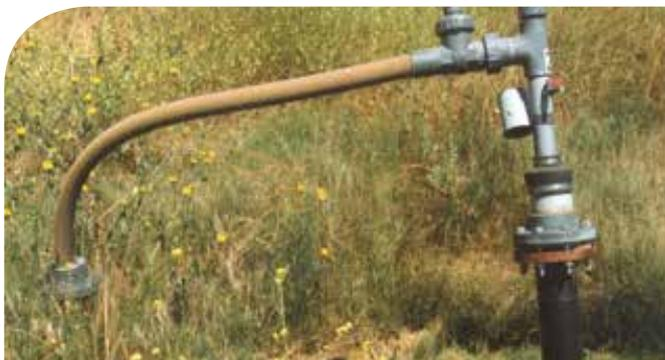
**Gambar 4.16:** Pangkal sumur gas yang relatif sederhana dengan titik sampling dan katup kontrol, yang melekat pada sistem angkut dan diperkuat oleh selang fleksibel.
