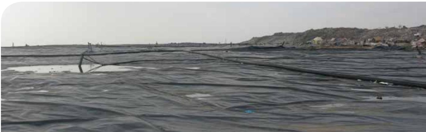
**Gambar 4.14:** Contoh sistem ekstraksi gas membran tertutup yang digunakan dengan kombinasi sumur vertikal, Bantar Gebang, Indonesia
