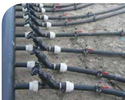
**Gambar 4.19:** Pengaturan manifold dengan katup sampel kecil dan jalur akses yang lebih besar untuk memasukkan instrumen pengukuran aliran
