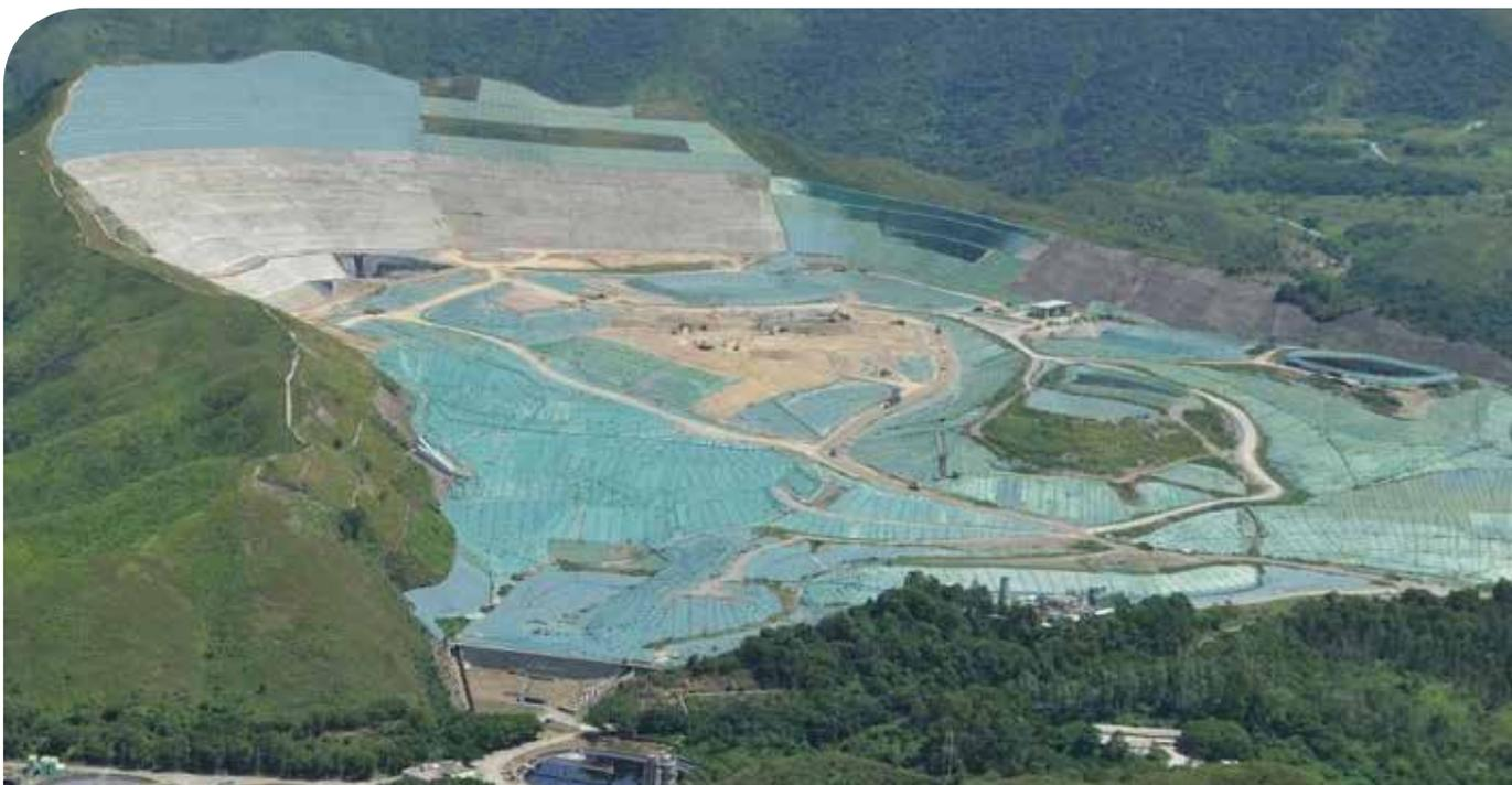
**Gambar 4.15:** Ekstensif menggunakan penutup membran sementara pada TPA besar di Hong Kong
