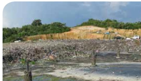
Gambar 4.6: Sumur gas dipasang sebelum dilakukan penimbunan, TPA Meulaboh, Aceh, Indonesia
