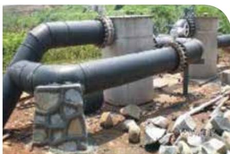
**Gambar 4.22:** Pot pengurasan bertugas dan siaga di pembangkit tenaga listrik, Bantar Gebang
