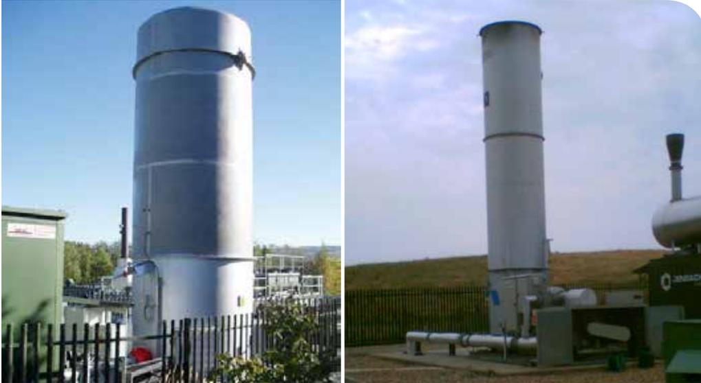
**Gambar 4.24:** Contoh pembakaran LFG tertutup dengan temperatur tinggi
